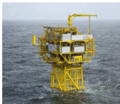
圖22 HVAC離岸變電站
