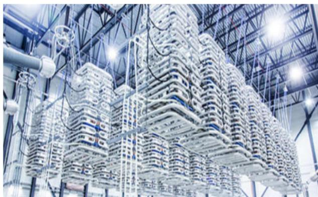
圖29 ABB ±525 kV 1400MW VSC HVDC
