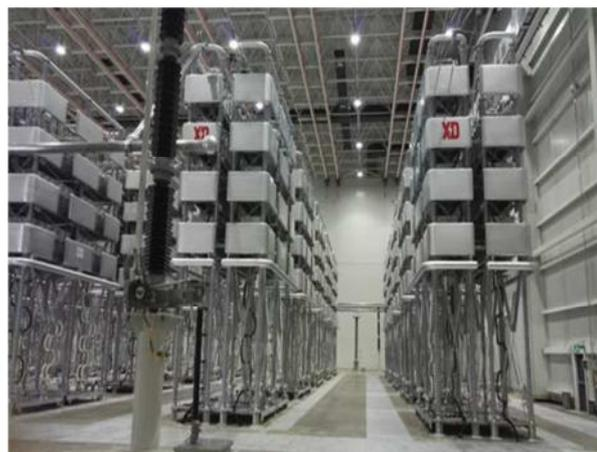
圖32 中國廣西 ± 350kV/1000MW HVDC轉換器閥組
