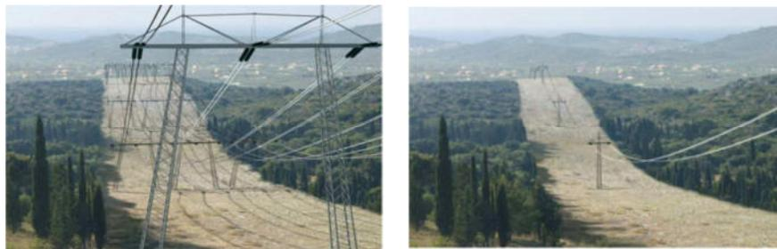
圖2 HVAC (左圖) 與HVDC (右圖) 線下通道比較
